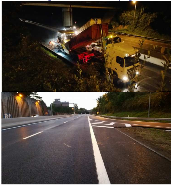
A20 Limoges – enrobés et marquage au sol
