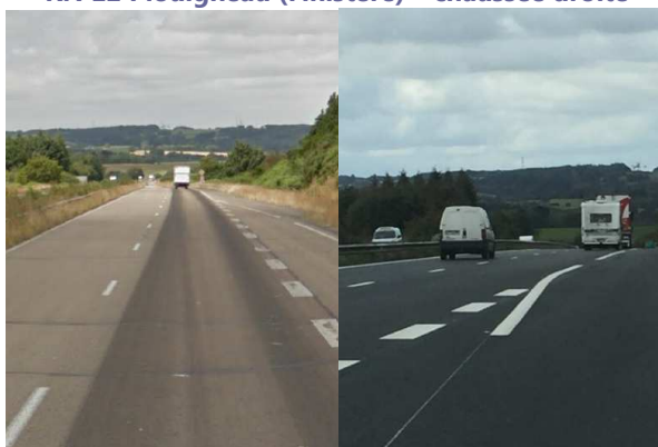
RN 12 Plouigneau (Finistère) – chaussée droite
