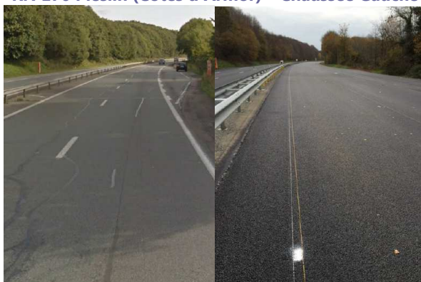
RN 176 Pleslin (Côtes d'Armor) – Chaussée Gauche
