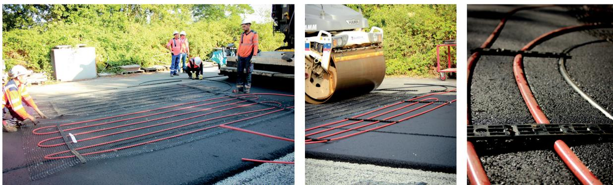
Installé en juillet 2017, le démonstrateur D1 est situé sur la voie d'accès au parking poids lourds de la gare de péage de l'autoroute A10 à Saint-Arnoult-en-Yvelines (78) sur le réseau Cofiroute (VINCI Autoroutes). Il représente 500m<sup>2</sup> de chaussée. Ce parking dispose d'un bâtiment (Espace clients de Cofiroute) dont le rez-de-chaussée sera à terme chauffé par le procédé Power Road®, associé au stockage inter-saisonnier (champ de sondes géothermiques verticales).
